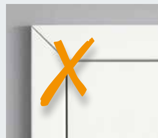
Dřevěná zárubeň s viditelným zkosením
